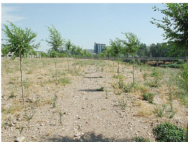
En la imagen se observa una actuación ya ejecutada: la construcción de una mota en la proximidad del puente romano en la margen derecha del río. La zona superior de este extenso caballón es transitable y ha sido objeto de plantación arbórea (*Ulmus pumila*).
