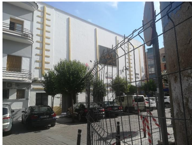
Cableado y señalética distorsionante
