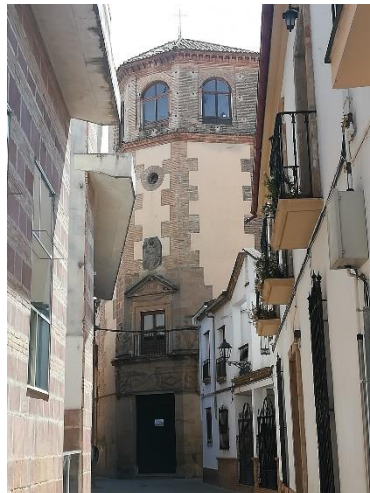
Cableado cruzando la calle Maestra
