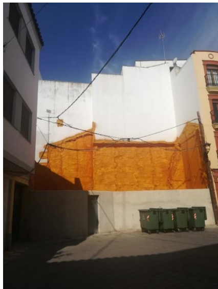
Solar en la calle Juan Robledo
