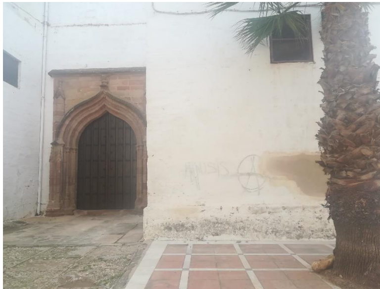
Fachada a la calle Villegas, pintadas
