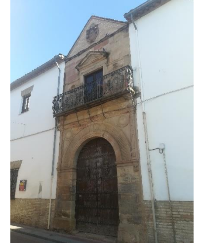
Cableado en el lateral de la calle Aduana
