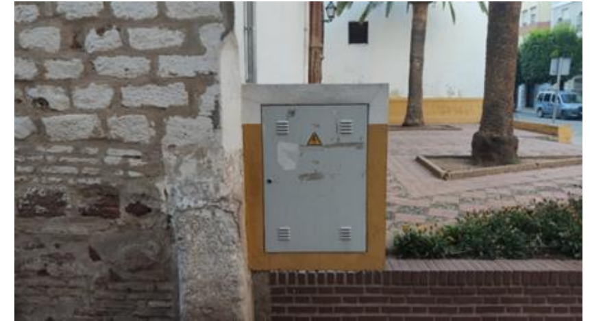
Fachada a la calle Aire, registro de instalaciones
