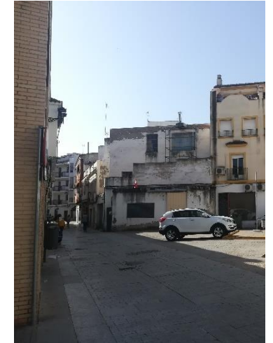
Edificaciones en mal estado en el entorno del Mercado de Abastos
