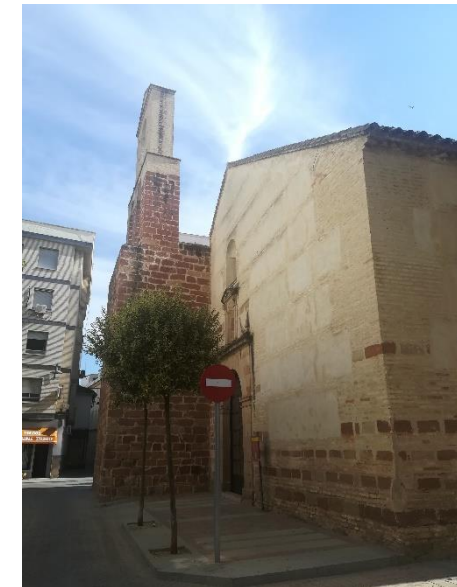
Fachada a la calle Fernando Quero, señalética
