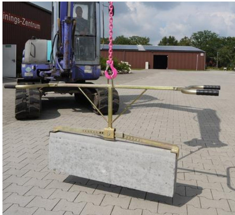
Fig.3 Colocación mediante maquina.
