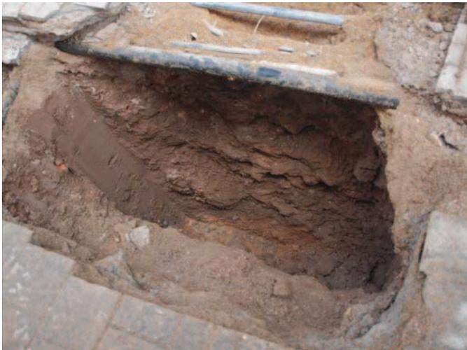
Fotografía 10. Cata de cimentación junto a muro lateral derecho en calle Mezquita
