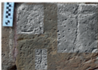
Figura 7: Contrafuerte izquierdo, lateral interior. Cluster de varias cruces con Monte Gógota. Uso de punzón y cincel
