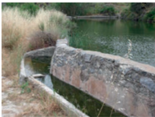
Lámina. 2. Repartidor de agua y atanor, pieza de barro con la que hacía la cañería.
