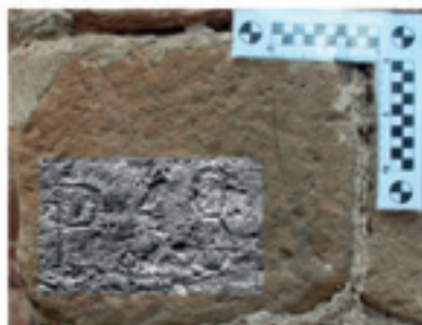
Figura 25: Contrafuerte derecho. Frontal.
