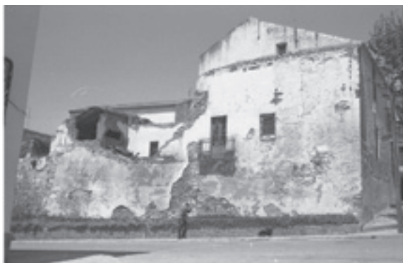
Lám. 8. Casa de la Escalera durante su demolición. Fotografía: Jesús A. Palomino León.
