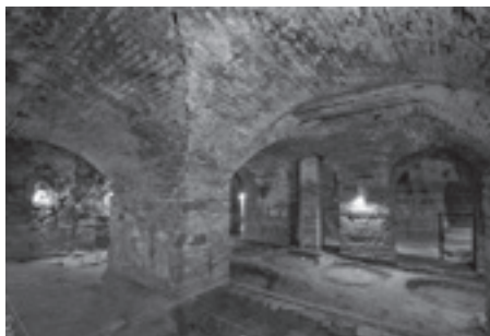
Lám. 7. Vista de una sala de los sótanos del castillo durante la excavación del año 2020. Fotografía: Víctor. A. García Aldehuela.
