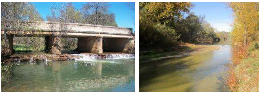
Figura 25.-Determinación en campo de los fenómenos de incisión (socavación del lecho) y acreción (elevación de la cota del lecho por sedimentación), como consecuencia de la alteración de los caudales líquidos y sólidos
